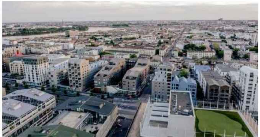
Le quartier des Bassins à flot, à Bordeaux Bacalan, est sorti de terre en quelques années.
